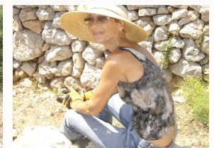
Pose du chapeau
